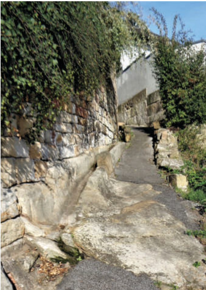
Die Leemhuis-Stiege in Bad Bentheim zeigt, wie diese besonderen Verbindungswege z.T. in den gewachsenen Fels gebaut wurden, aber auch, wie sie z.T. mit Fremdmaterial eher notdürftig erhalten werden. Foto: Stiegenfreunde Bad Bentheim
