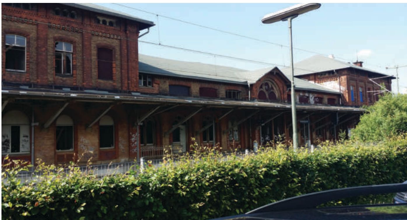
Der Bahnhof Nordstemmen, eines der bedeutendsten Bauwerke des hannoverschen Architekten Conrad Wilhelm Hase, ist integraler Bestandteil des Ensembles um das nahe Schloss Marienburg südlich Hannover, 1853/54 erbaut, ist in einem beklagenswerten Zustand. Foto: Thomas Krueger.
