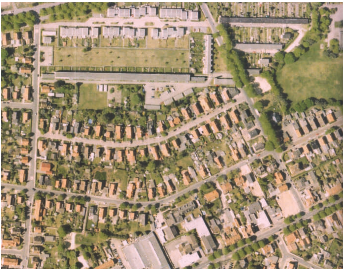
Die Siedlung Blumläger Feld Nord des Architekten Otto Haesler in Celle. Foto: LGLN.
